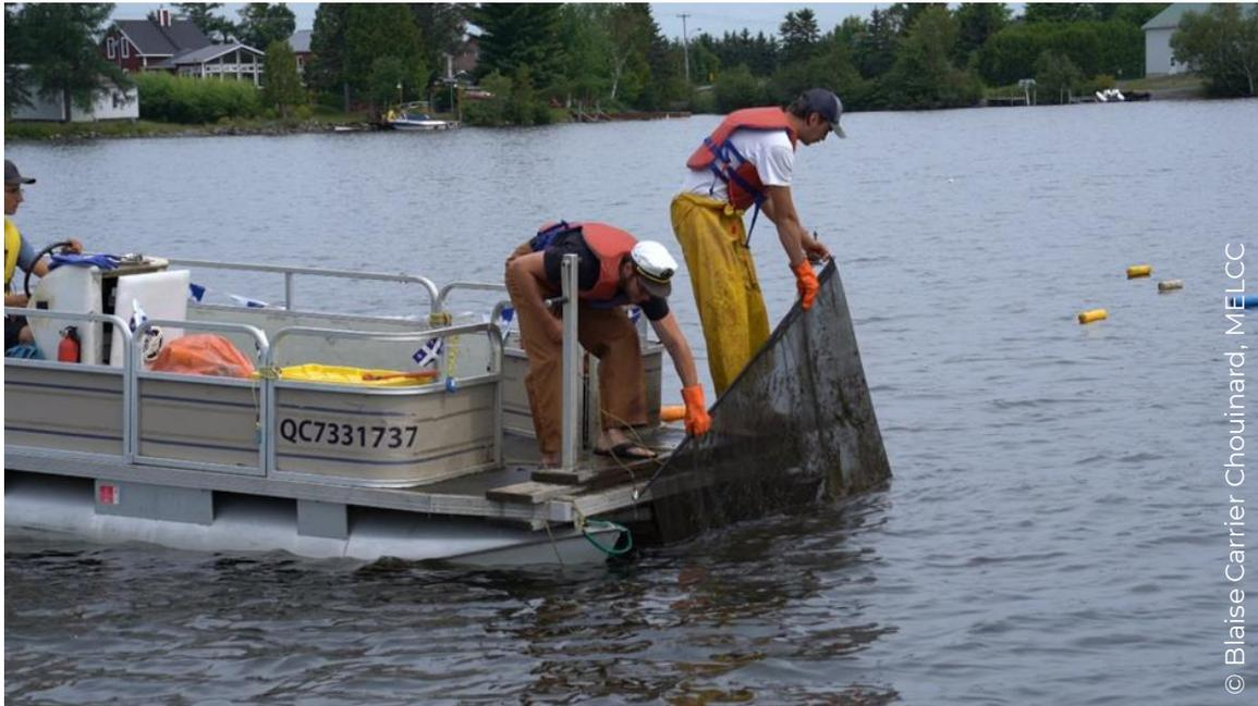
**Figure 33. Retrait de la toile de l'eau en préparation de la rouler.**
