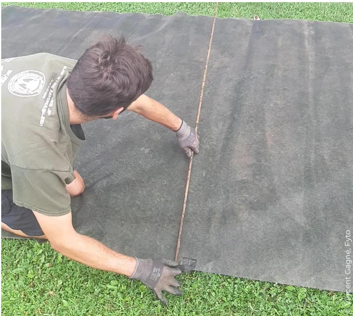
**Figure 29. Formation d'installation des toiles, lestage.**
