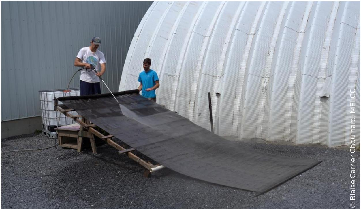
Figure 49. Lavage d'une toile avec laveuse à pression à eau chaude.
