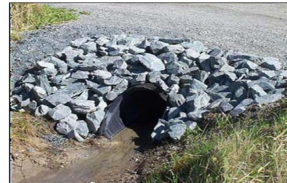
Si un muret est aménagé aux extrémités du ponceau, le muret doit être érigé avec des pierres plates et rectangulaires. De plus, il est important d'installer un géo-textile derrière le muret afin de retenir les petites particules et ainsi éviter l'érosion de l'entrée charretière.
